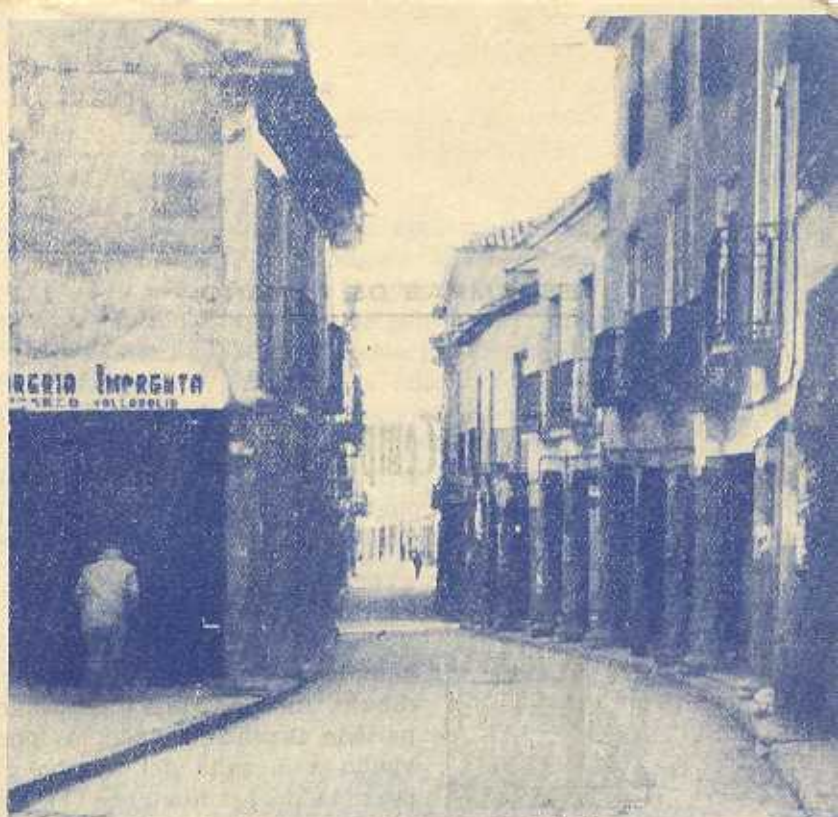
Calle de Lázaro Alonso con el nuevo pavimento y alcantarillado.
